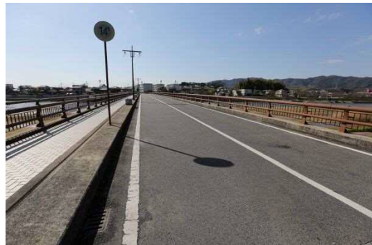
最も長い橋梁:千歳橋(鋼桁橋 橋長142.8m 1988年完成)
