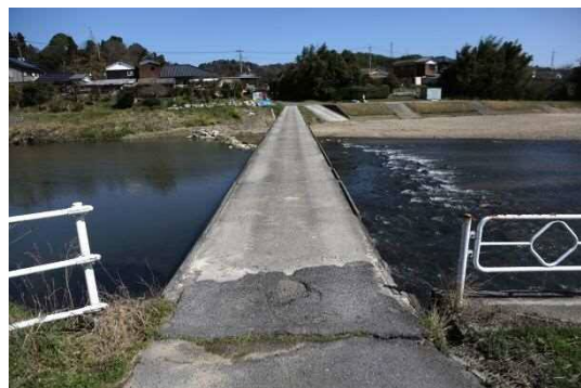
特殊な橋梁:旭橋(沈下橋(潜水橋) 橋長70.7m 1958年完成)
