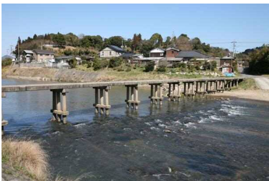
特殊な橋梁:旭橋(沈下橋(潜水橋) 橋長70.7m 1958年完成)
