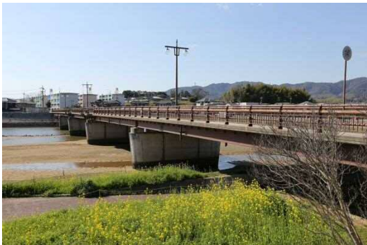
最も長い橋梁:千歳橋(鋼桁橋 橋長142.8m 1988年完成)
